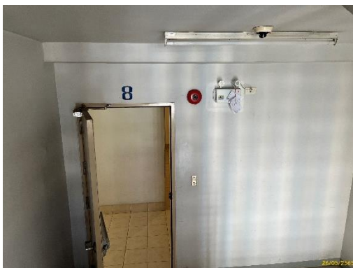
โทรศัพท์ฉุกเฉินและอุปกรณ์แจ้งเหตุ
