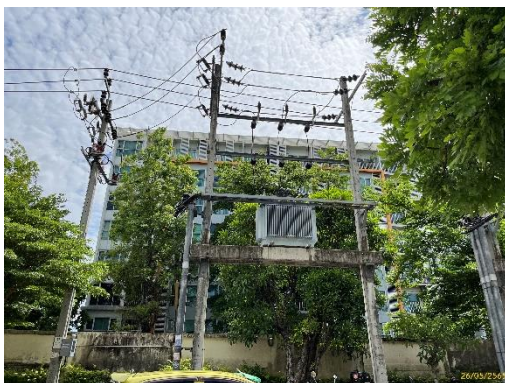
หม้อแปลงไฟฟ้าประจำอาคาร ขนาด 630 KVA
