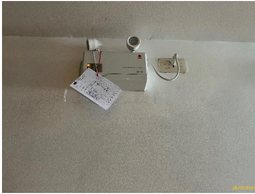
Battery ไฟฟ้าสำรอง ภาพที่ 1.3.7-1 (ต่อ) ระบบไฟฟ้า
