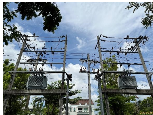
หม้อแปลงไฟฟ้าประจำอาคาร ขนาด 630 KVA
